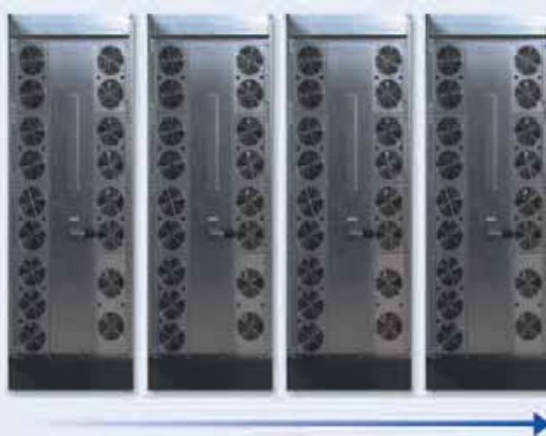
Modularidade horizontal convencional: UPS em paralelo
