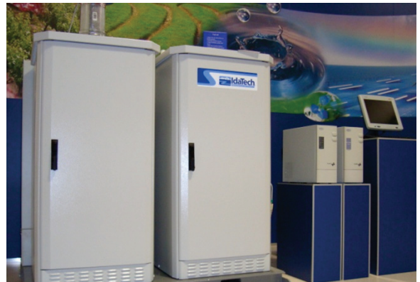
UPS Chloride collegati a celle a combustibile IdaTech visibili presso lo stabilimento di Castel Guelfo (BO),
